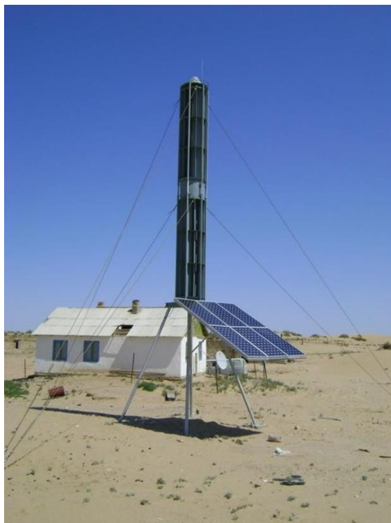
Рисунок 1А – ВВТ (ВРТБ, 2 кВт) для питания объекта «Кожаказган»
