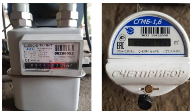
Сурет 3.4 – Тұрмыстық газ есептегіштер: а) ELSEL BK-G4T; б) СГМБ-1,6 ТК
